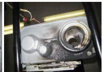
写真18 吸気口下部の状況
