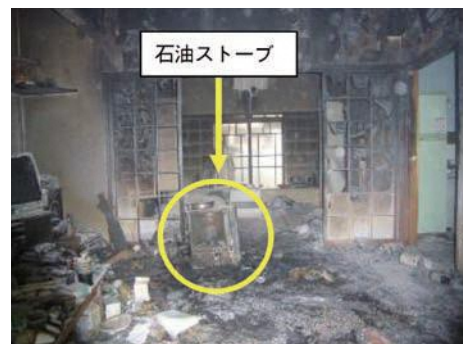
写真1 出火室の状況
