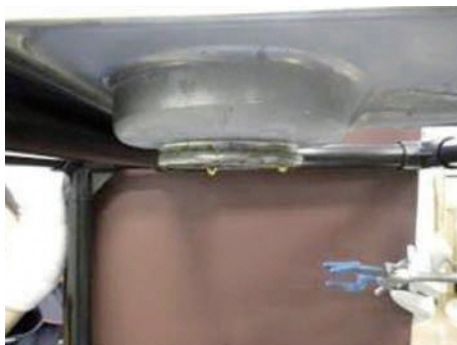
写真12 液化した灯油の付着状況2
