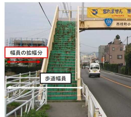
国道139号(山梨県西桂町)
