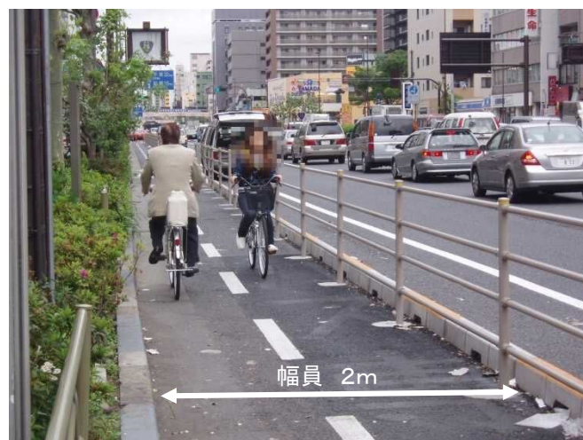
国道14号(東京都江東区)
