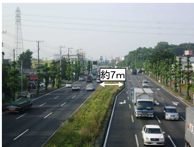
国道17号(埼玉県さいたま市)
